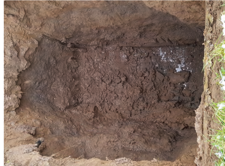
S 2 Brücke S
